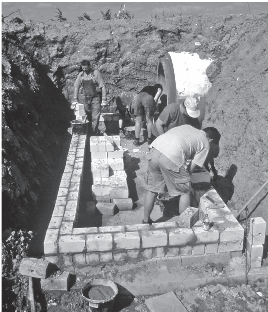
Neben dem Erfassen der Fledermausbestände gehört auch das Anbieten von neuen Quartiermöglichkeiten für Fledermäuse zu den Aufgaben der AG Fledermausschutz. Hier wird ein Winterquartier gebaut.
