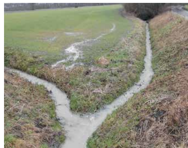
Bodenerosion wird hingenommen (Schöppingen, Kreis Borken, Zufluss zum Asbecker Mühlenbach)
