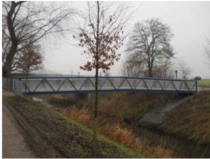
ABBILDUNG: Radwegbrücke Mühlenstraße (Quelle: Stadt Bergkamen, StA 61)
