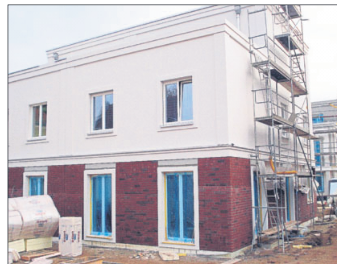
Neues Haus mit mineralischem Putz
