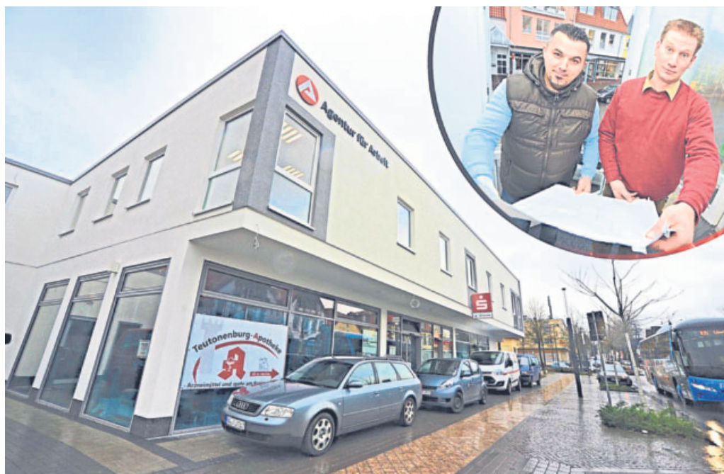
Die Bauarbeiten am neuen Büro- und Geschäftshaus am Paderborner Tor 99 in Warburg sind abgeschlossen. Investor Asim Rizvani (kleines Foto, links) und Handwerker Stefan Bolte standen während der Bauphase regelmäßig in Kontakt. Fotos/Montage: Christian Geschke
