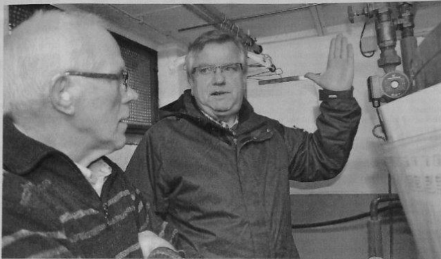
Rudolf Wendering (links) lässt sich von Energieberater Thomas Venhorst erklären, was er an der Heizungsanlage austauschen lassen kann. Foto: Claudia Feld
