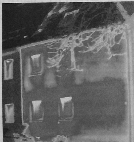
Bei der Thermografie deckt eine Wärmebildkamera Schwachstellen in der Dämmung deutlich auf.
