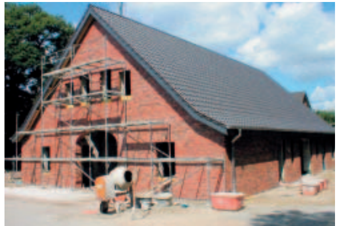
Landwirtschaftliches Betriebsgebäude vor und während der Umbauphase
