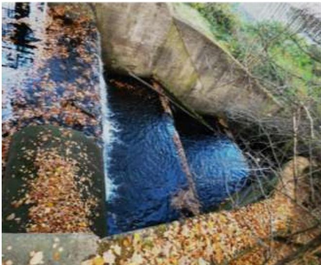
Abfluss des Pocheweiher mit betonierten Kaskaden
