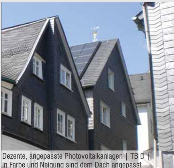
Dezente, angepasste Photovoltaikanlagen | TB D | in Farbe und Neigung sind dem Dach angepasst
