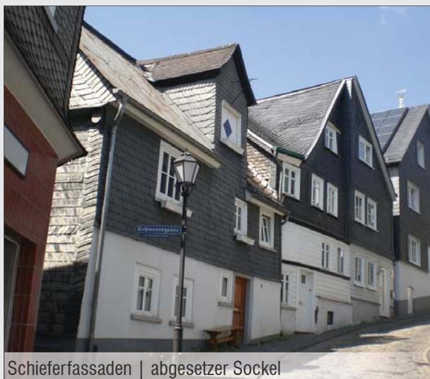
Schieferfassaden | abgesetzter Sockel
