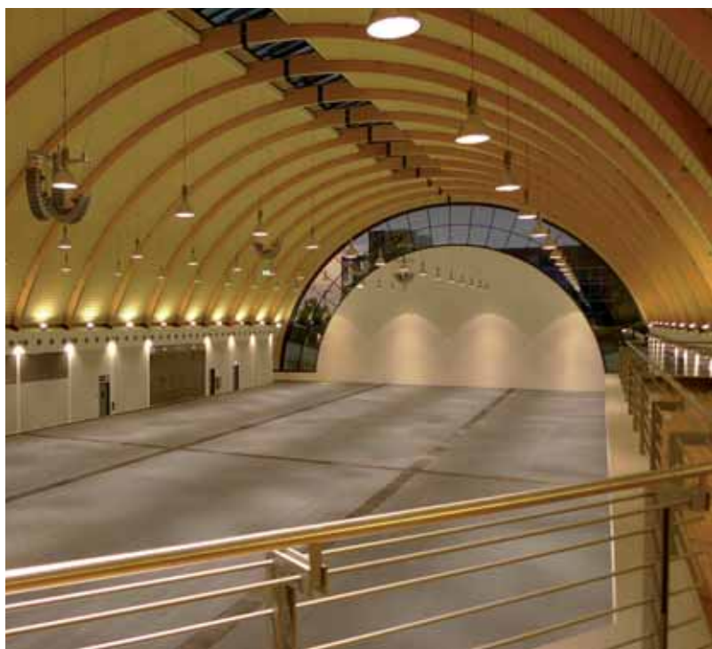
Neue Ausstellungs- und Veranstaltungshalle der Stadthalle Bielefeld
