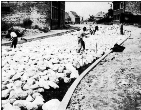
Bau der neuen Ortsdurchfahrt (B 51)
