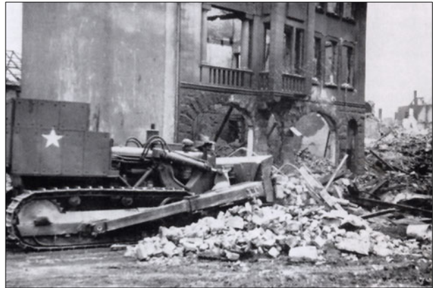
US-Räumpanzer schieben die Trümmer zur Seite, um eine Durchgangsstraße zu bauen
