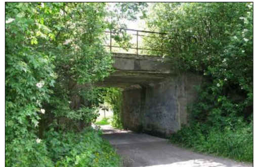
Brücke der stillgelegten Verbindungsstrecke Dortmund–Münster
