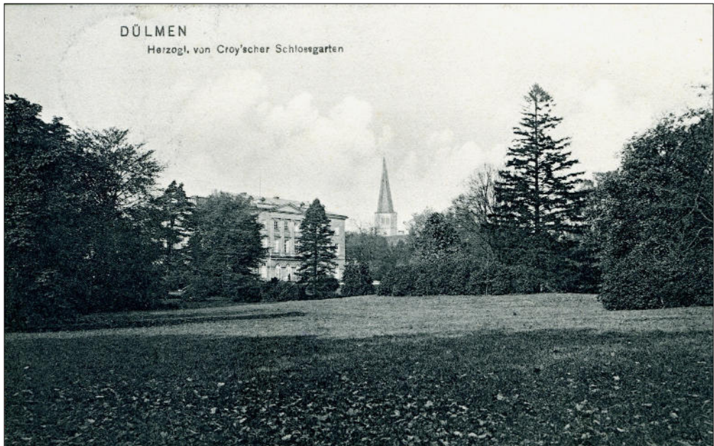
Englische Parkanlage mit dem Schloss der Herzöge von Croÿ. Im Hintergrund der Turm der Viktorkirche
