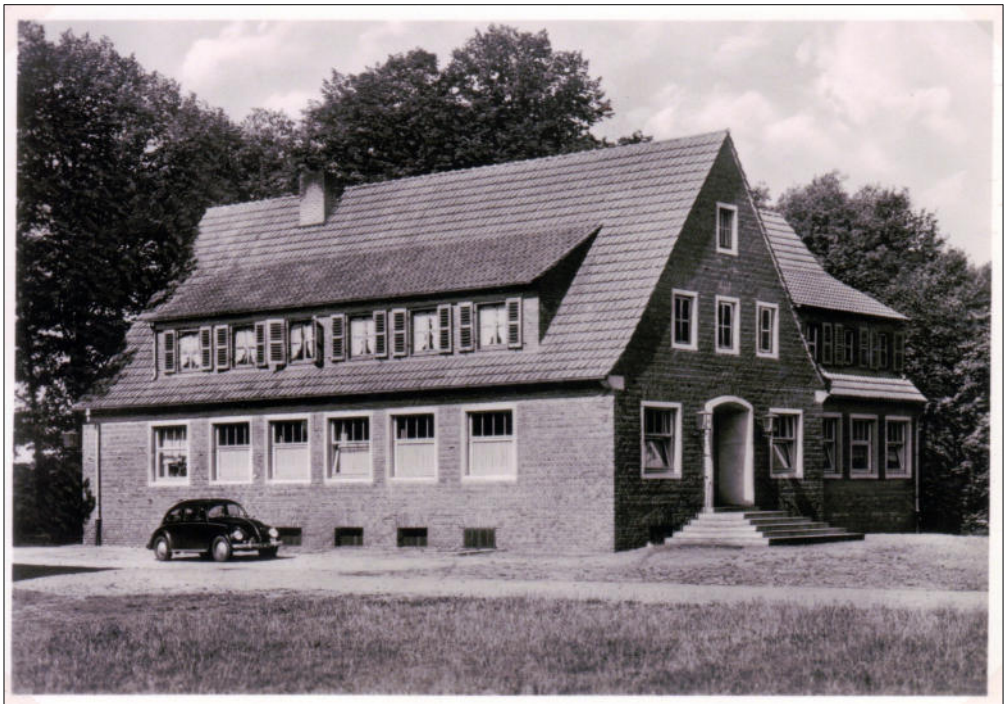
Neubau des im 2. Weltkrieg durch Bomben zerstörten Wohnhauses der Großen Teichsmühle aus den Jahren 1950/51
