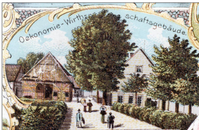
Große Teichsmühle um 1900, links: Scheune, rechts: Wohngebäude
