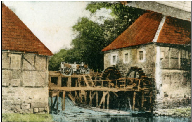
An der alten Kornmühle der Großen Teichsmühle sind vor 1900 noch zwei mächtige unterschlägige Mühlenräder zu erkennen.
