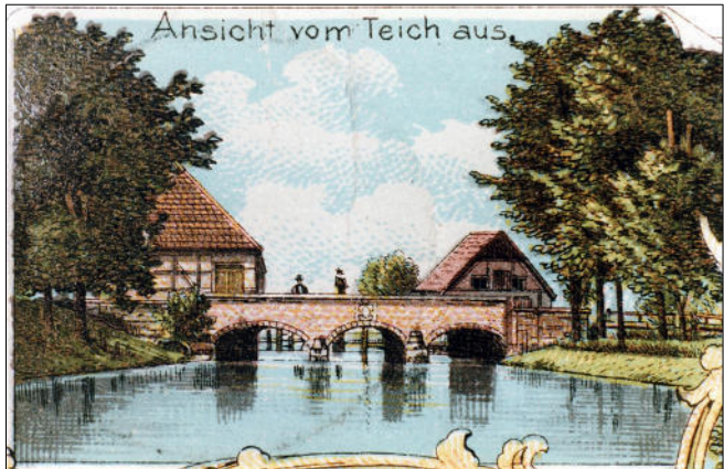
Ansicht der Mühlenhäuser der Großen Teichsmühle mit der steinernen Brücke. Über dem mittleren Brückenbogen ließ der damalige Brückenbauer Fürstbischof Friedrich Christian im Jahre 1705 sein Wappen anbringen.
