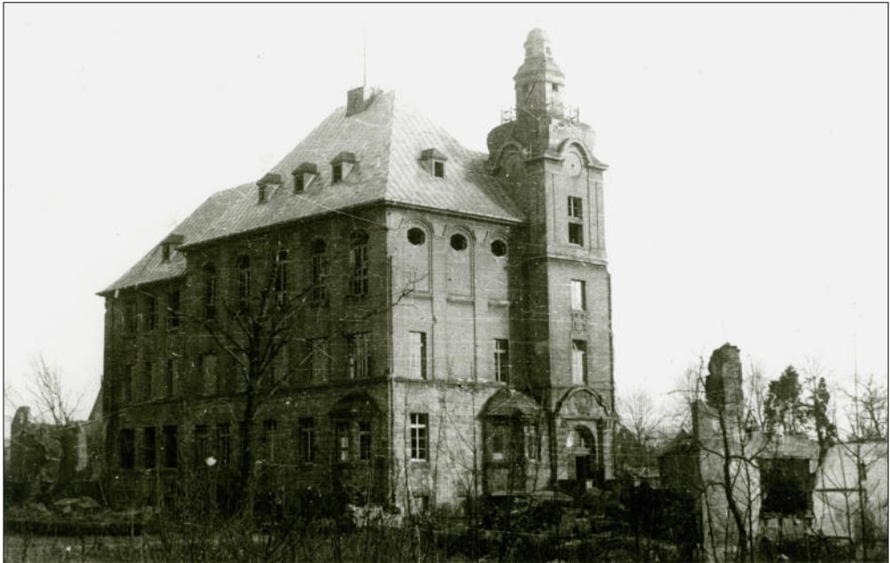
Das durch Bombentreffer zerstörte Gymnasium am Nonnenwall
