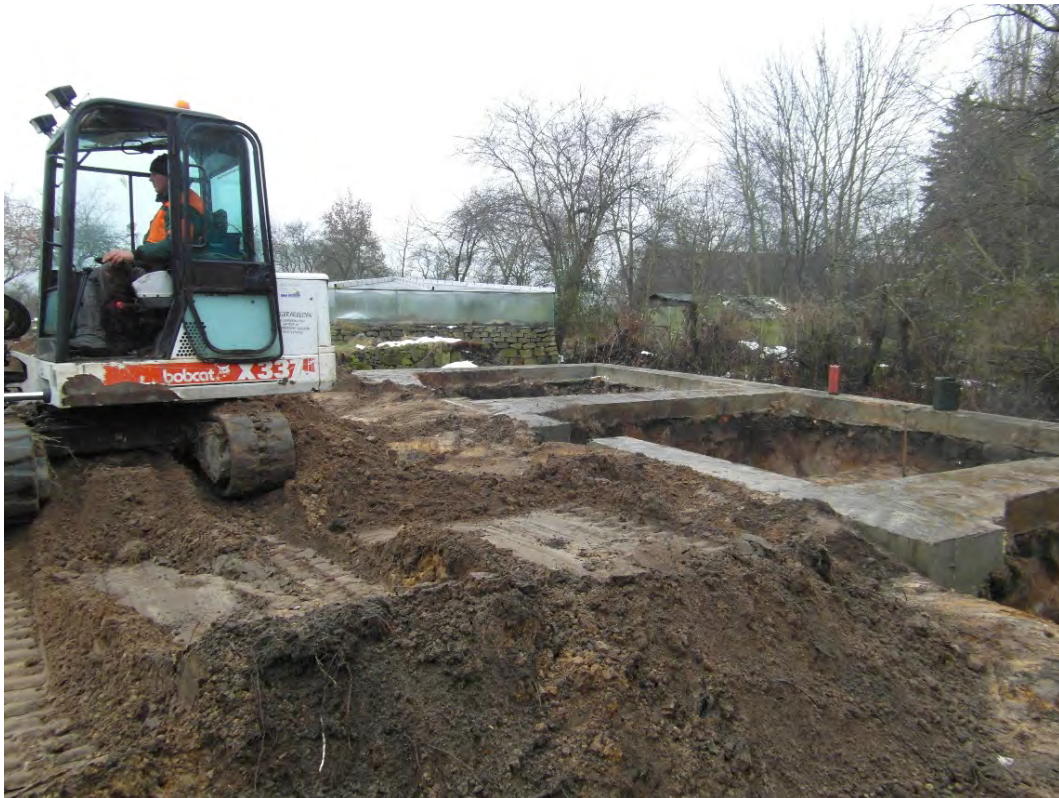
Abbildung 4: Nachdem der Beton der Fundamente getrocknet war, wurde die Erde des zukünftigen Terrariums ausgebaggert (Foto: M. Bisping)
