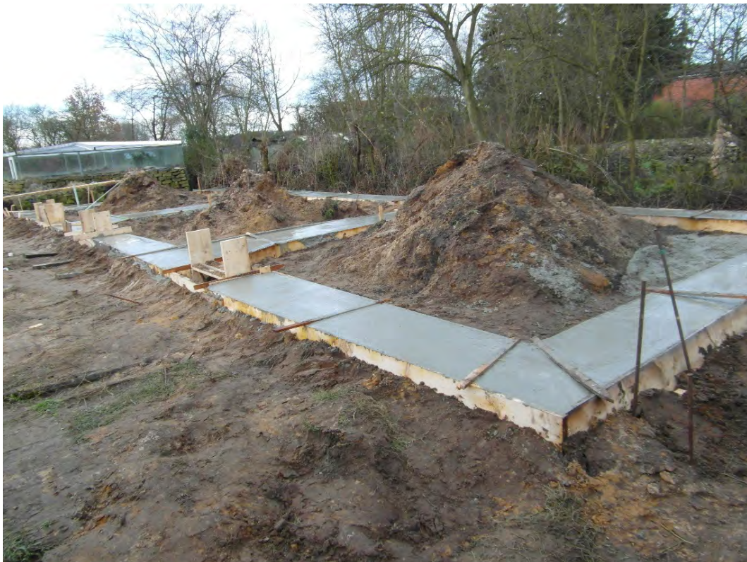
Abbildung 3: Die Fundamente sind 1,8 m tief, damit sich die Knoblauchkröten später passend tief eingraben können (Foto: M. Bisping)
