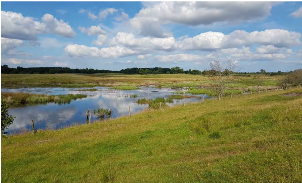
Abbildung 5: Das ca. 6.000 qm große, wiederhergestellte Gewässer ist ein typisches Soll in der Weidelandschaft am Treßsee südlich von Flensburg. Durch Verschluss eines Grabens und durch die Herstellung eines etwa 0,80 cm hohen Walles wurde die Wiesensenke wieder geflutet, die zuvor durch Graben und Drainagen sowie Absenkung des Grundwasserstandes durch Seespiegelregulierung entwässert war. Durch Ganzjahresbeweidung werden die Uferstrukturen offen gehalten. Knoblauchkröten haben das Gewässer wiederbesiedelt (3 Rufer in 2015). Das Altgewässer (Foto 7) ist etwa 500 m entfernt. (Foto: H. Drews)
