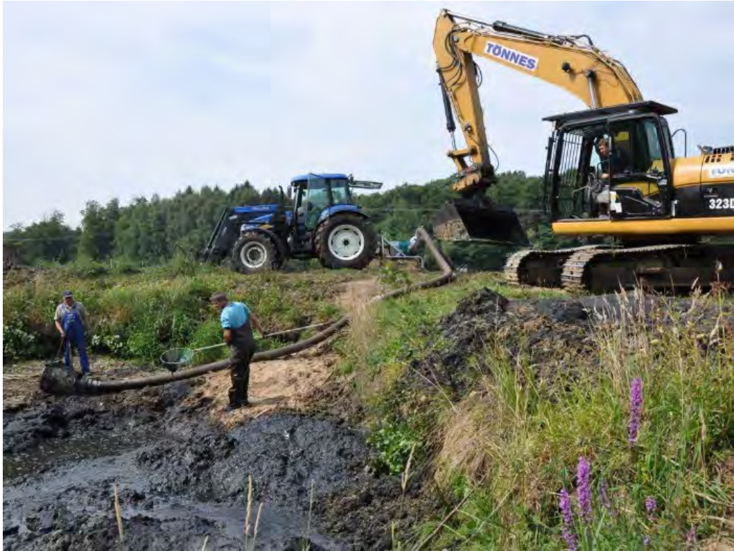
Abbildung 8: Baggerarbeiten in der Emsaue In den Pöhlen. Drei neue Laichgewässer werden geschaffen und die ehemaligen Fischteiche ausgepumpt. (Foto: A. Beulting)
