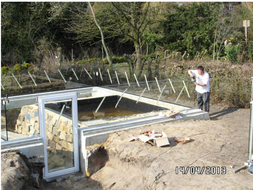
Abbildung 5: Zur besseren Belichtung und als Windschutz setzt Michael Bisping Glasscheiben auf die Fundamente auf (Foto: M. Bisping)
