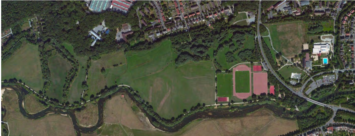
Abbildung 2: Das Gebiet Rothe Beke liegt im Überschwemmungsbereich der Lippe und grenzt im Norden an die Terrassenkante (Luftbild: Geobasisdaten der Kommunen und des Landes NRW © Geobasis NRW 2016)
