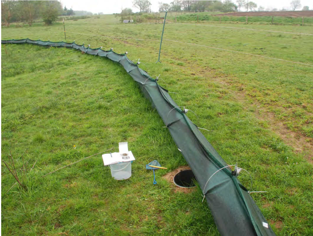
Abbildung 19: Amphibienschutzzaun mit Dach und damit Überkletterungsschutz im NSG In den Pöhlen beim Aufbau (Foto: C. Göcking)
