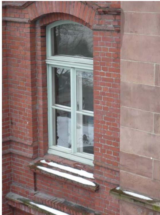
Beispiel einer Fenstersanierung mit zusätzlicher innerer Fensterebene Kreuzform
