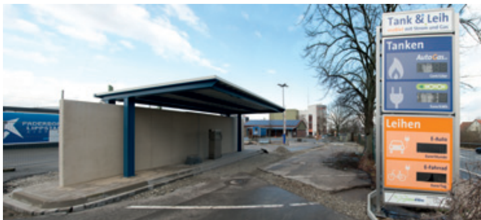
Blick von der Kreuzung Detmolder-/Otto-Brenner-Straße auf die GreenStation der moBiel in Sieker.
