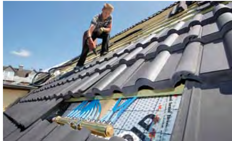
Solaranlage verschwindet unterhalb der Dachpfannen. Foto: Dachziegelwerke Nelskamp GmbH
