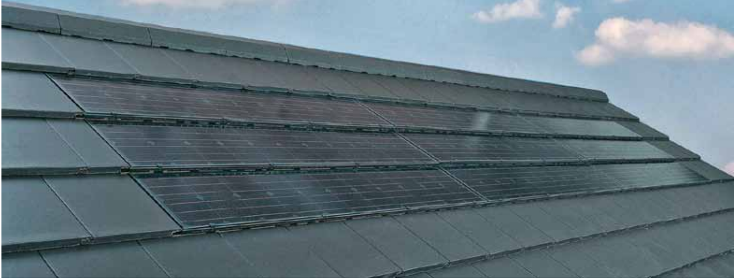
Die neue Solaranlage optimal ins Dach integriert. Foto: Braas GmbH.
