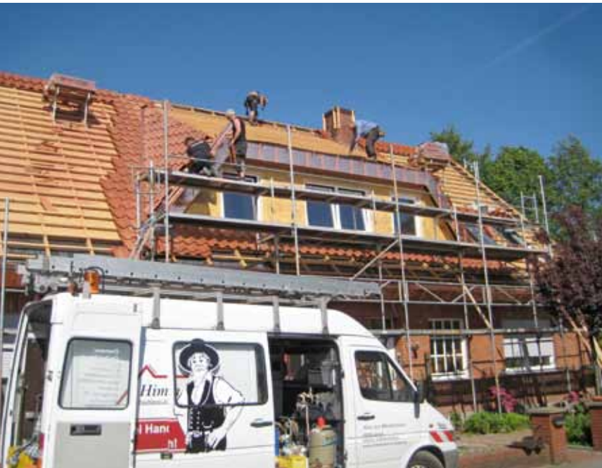
Alle Dacharbeiten müssen gut geplant und sicher umgesetzt werden. Foto: Himmelreich GmbH.
