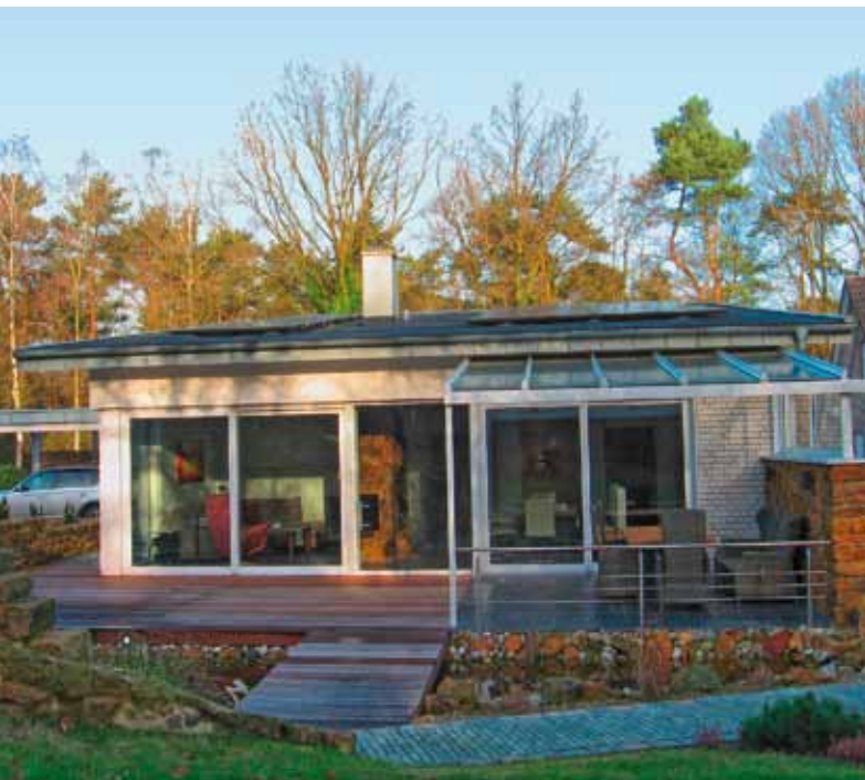
Wohnkomfort pur: Blick vom Süden auf das neue Wohgebäude am Stadtrand von Ibbenbüren.
