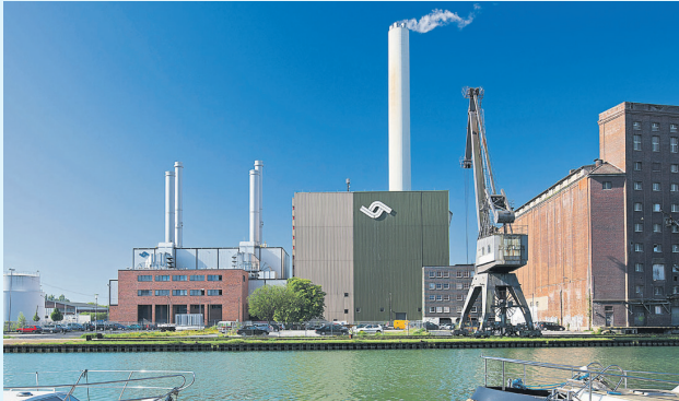
Am Hafen erzeugt die klimaschonende GuD-Anlage Strom und Fernwärme für Münster.
