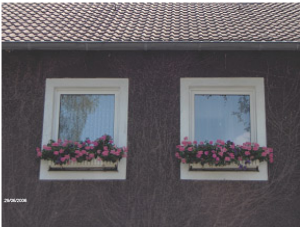
Die hellen Fenster- und Türfaschen heben sich von den dunklen Putzflächen ab.
