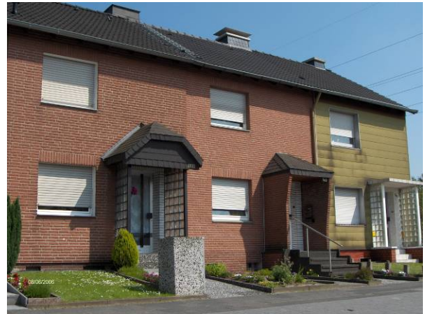
Verblendmauerwerk und Vorhangfassaden lassen die ursprüngliche Struktur nicht mehr erkennen. [-]
