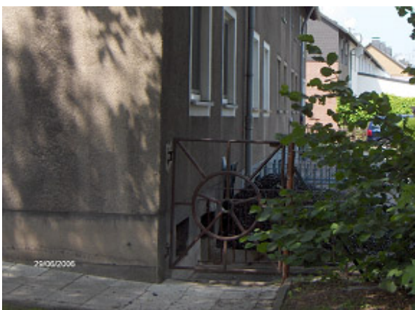
Die Gebäudesockel springen leicht zurück und sind mit Glattputz versehen.
