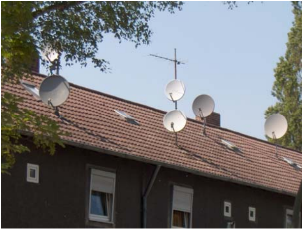
[-] Beliebig angebrachte Satellitenanlagen stören die ansonsten ruhige Dachlandschaft.
