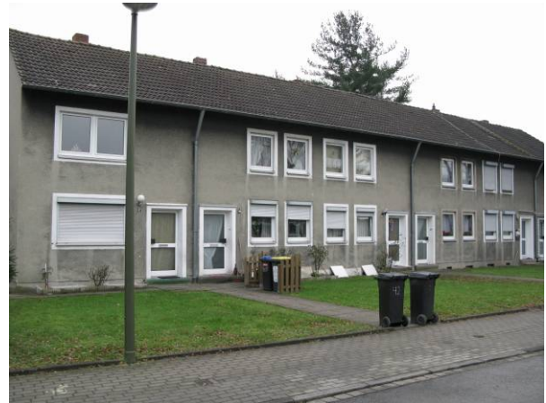
Bei Haustyp A sind die Fenster- und Türöffnungen insgesamt sehr symmetrisch angeordnet.
