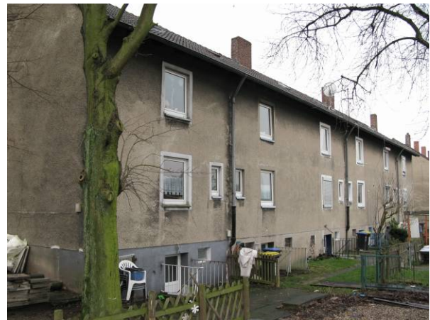
An den Gebäuderückseiten sind bislang keine Anbauten vorhanden.
