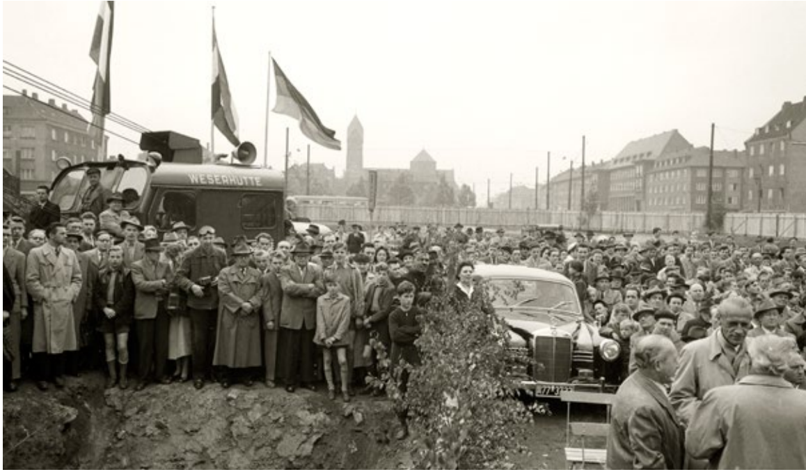
Feierlichkeiten zur Grundsteinlegung des Musiktheaters (1956)
