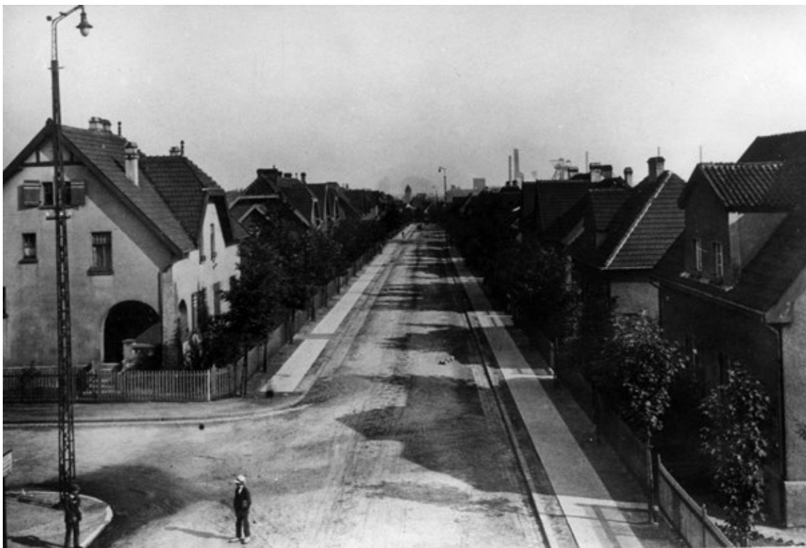
Blick in die Mühlenstraße in der Kolonie Bergmannsglück (1909). Die im Hintergrund erkennbare Zeche war um die Wende zum 20. Jh. mit ihren umfangreichen Grubenfeld und ihrer modernen Zechensiedlung der Prototyp einer Großzeche.
