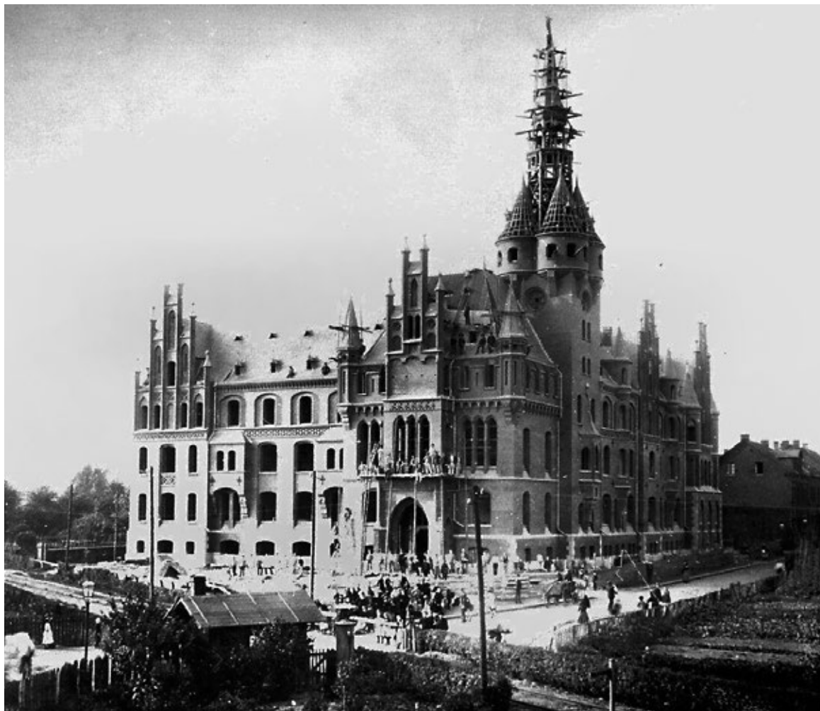
Das Gelsenkirchener Rathaus im Bau (1896)
