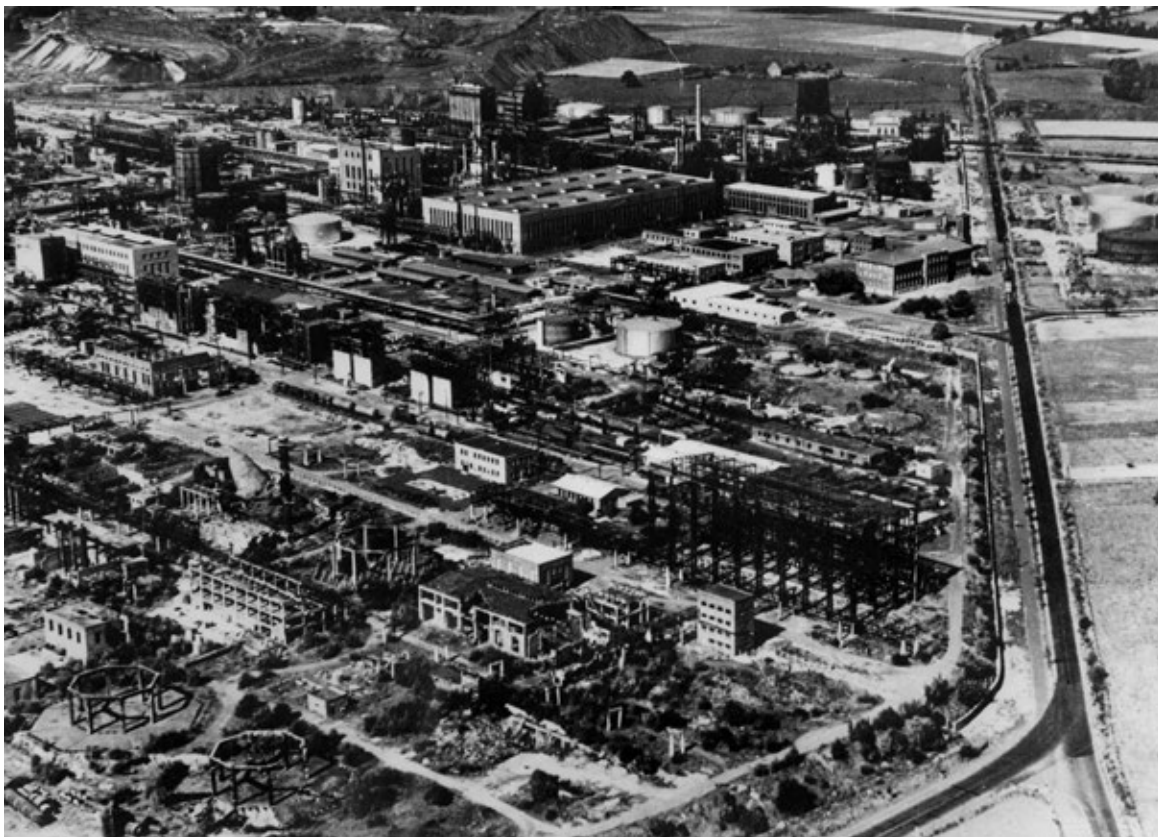
Die zerstörten Anlagen der Hydrierwerk Scholven AG (1944)
