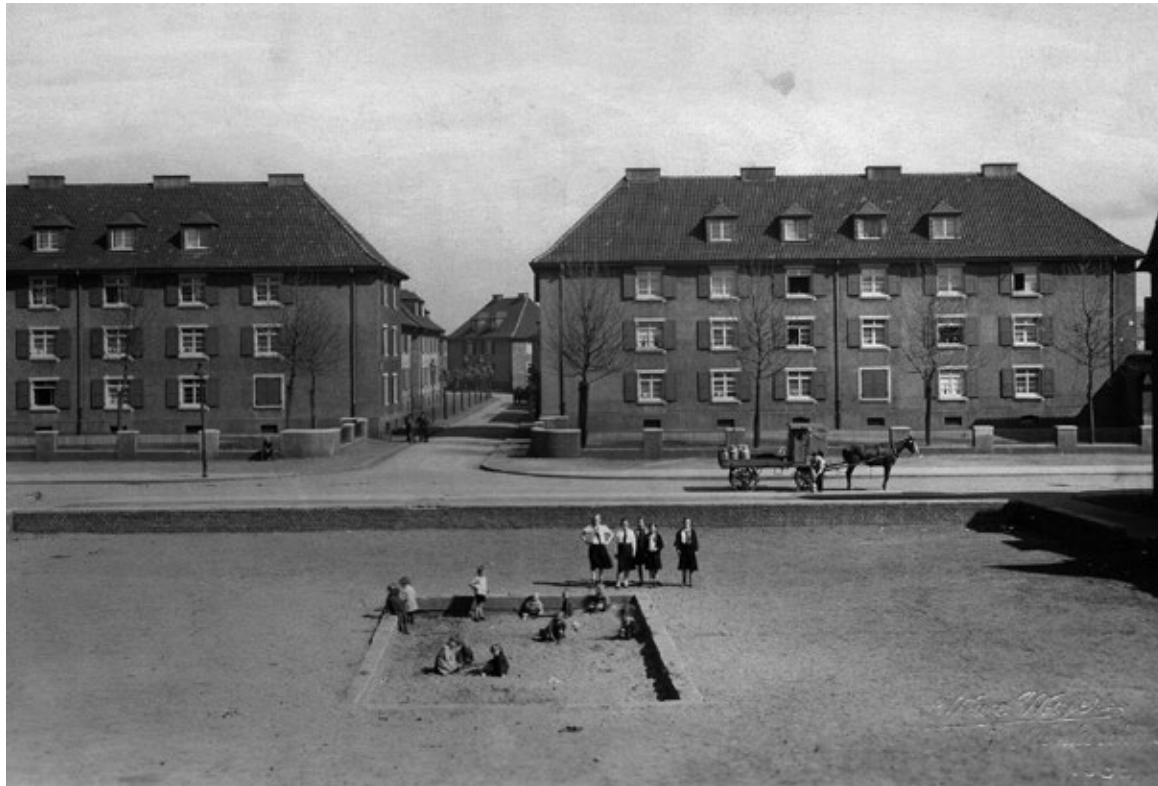
Blick auf die Kolonie »Im Sundern« der Zeche Graf Bismarck, Baujahr 1925/1926, Sandkasten mit Kindergruppe (1935). Die Konstruktion neuerer Arbeitersiedlungen wie der Abgebildeten zielte unter anderen auf eine effiziente Nutzung des zur Verfügung stehenden Raumes ab.
