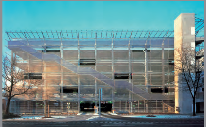
Großparkhaus Klinikum Darmstadt | Lengfeld & Wilisch, Darmstadt
