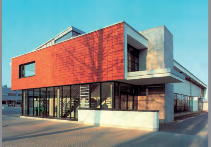
Bauhof des Wasser- und Schifffahrtsamtes, Aschaffenburg | Lengfeld & Wiliisch, Darmstadt
