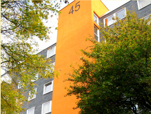
25 Sanierte Gebäude VBW
