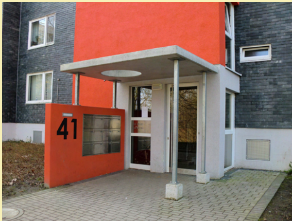
26 Eingangsbereich nach Farbkonzept
