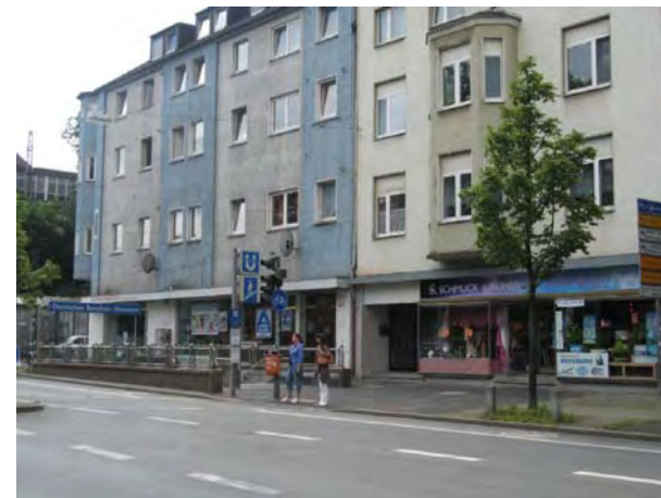
Foto 9: Nahversorgungszentrum Herner Straße
