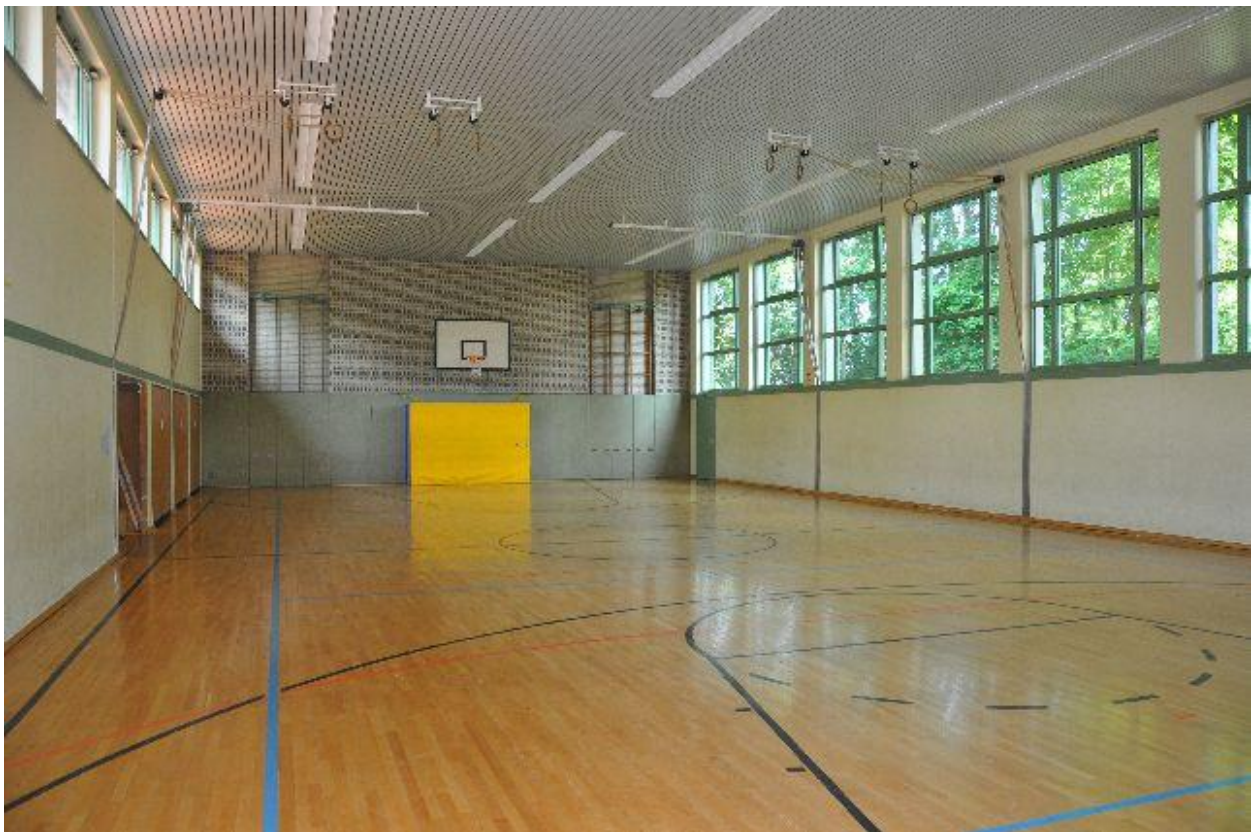
Turnhalle Grundschule Rehme-Oberbecksen
