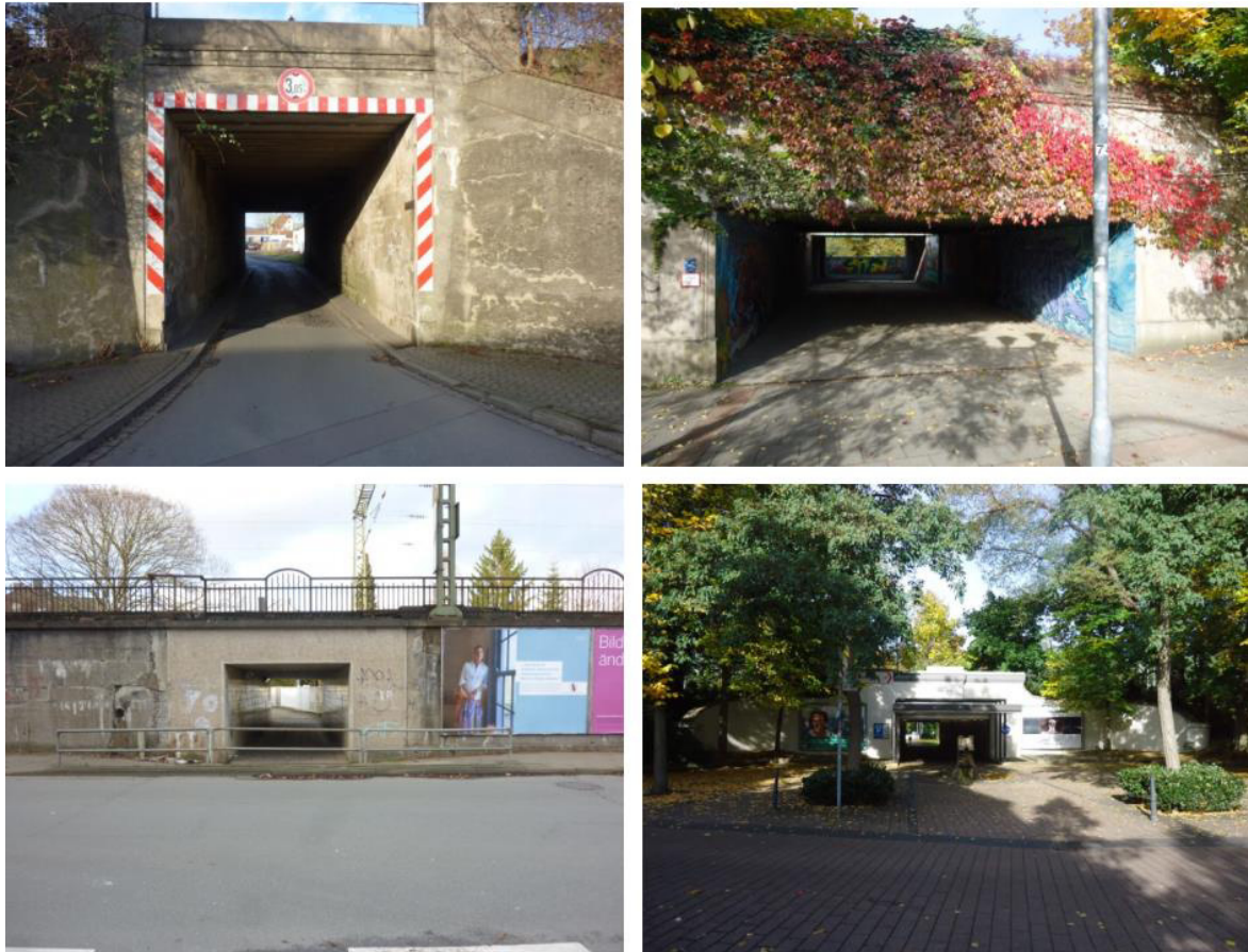
Abb. 73: Bahnunterführungen an der Tannenbergsstraße, am ZOB, an der Heinrichstraße sowie an der Lennestraße
