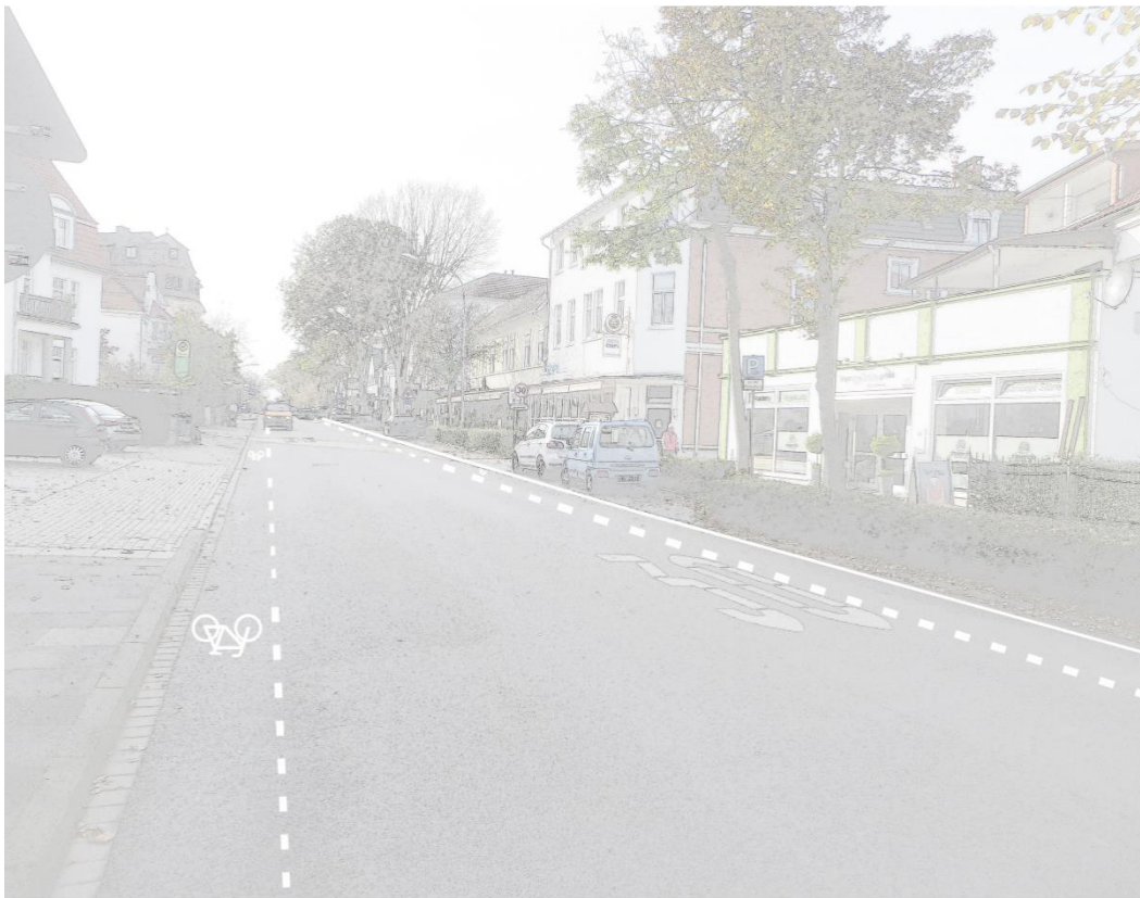
Abb. 72: Herforder Straße nach Einrichtung eines Schutzstreifens
