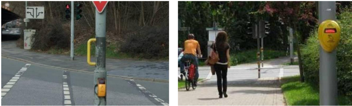
Abb. 66: Marler Ampelgriff (links), vorgelagerter Anforderungstaster (rechts)
