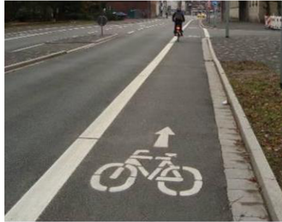
Abb. 62: Radverkehrsführung auf der Fahrbahn: Schutzstreifen (links), Radfahrstreifen (rechts)
