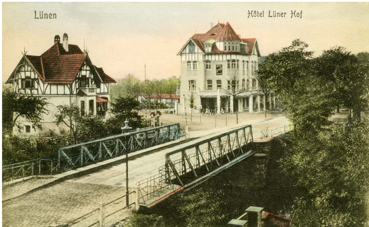
Bäckerstraße / Ecke Parkstraße mit Sesekebrücke, um 1905
