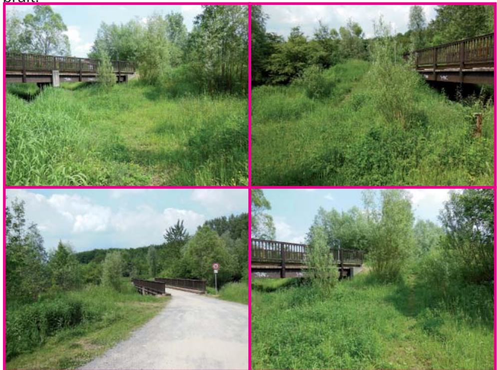
Süggelbrücke in Lünen Gahmen (Fotos B. Schürmann)
