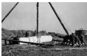
Das Verlegen einer Trinkwasserrohrleitung ist damals wie heute immer noch Schwerstarbeit – trotz technischer Hilfsmittel.
