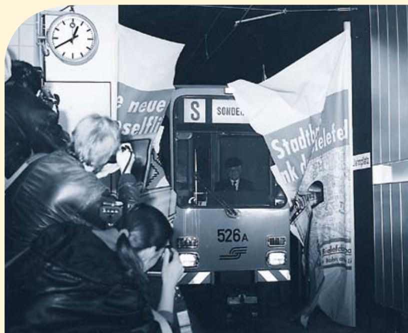
Am 28. April 1991 konnte das größere Tunnel-system an den Start gehen.
