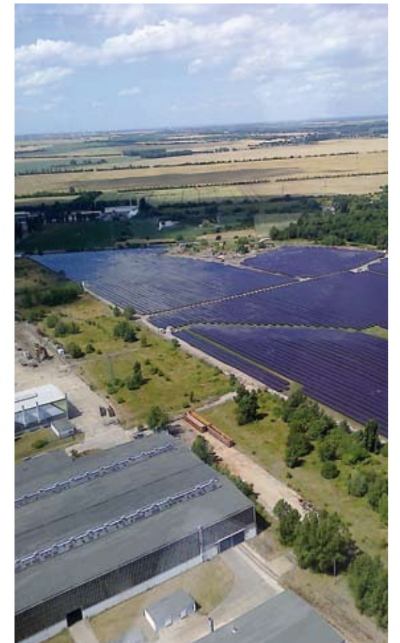
Aus der Vogelperspektive: Die Photovoltaikanlage in Calbe verfügt über mehr als 48.000 Dünnschichtmodule.
