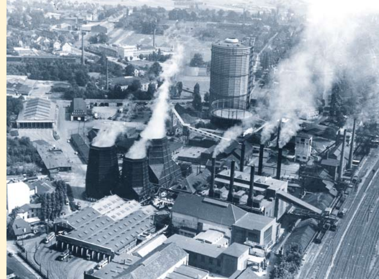
Luftaufnahme des Werksgeländes um 1954
