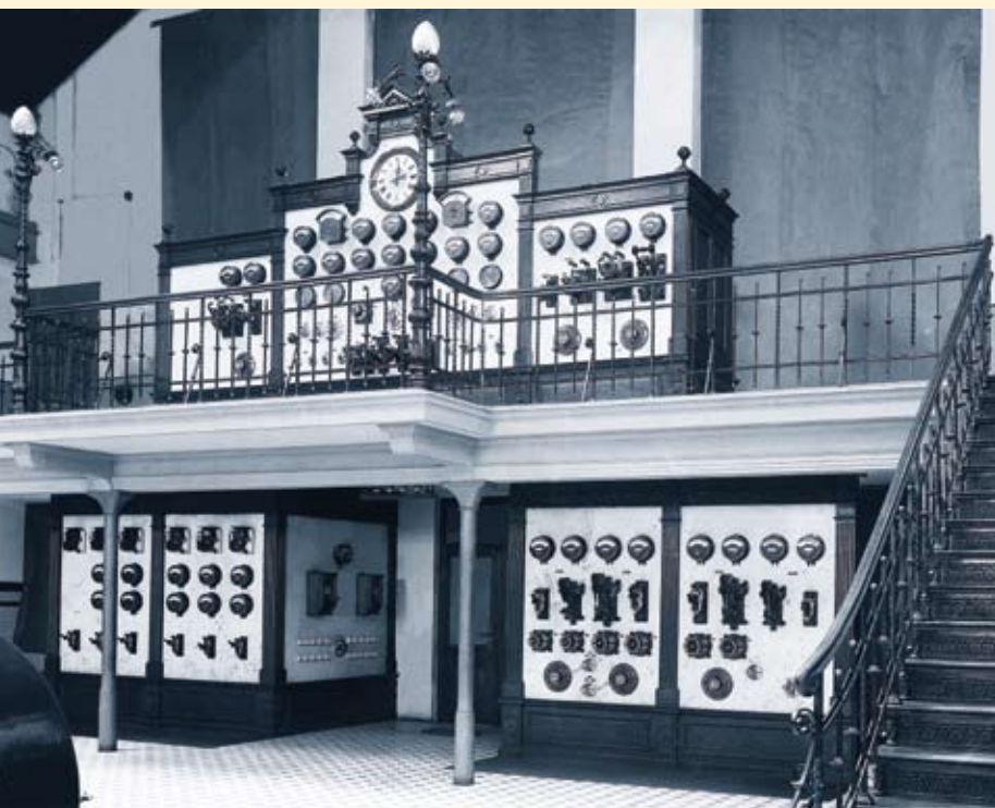
Die Schalttafel im Kraftwerk mutet fast wie ein »Altar« der Technik an.
