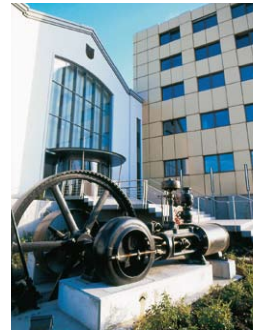
Im Jahr 2001 wurde die zum Kundenzentrum umgebaute ehemalige Turbinenhalle eröffnet.
