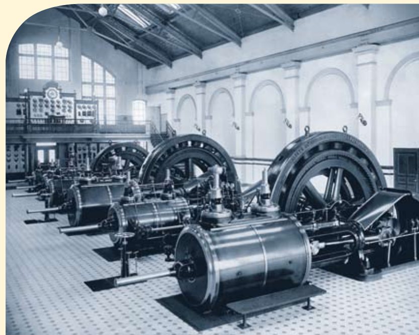
Ein Blick in die Turbinenhalle des Kraftwerkes
