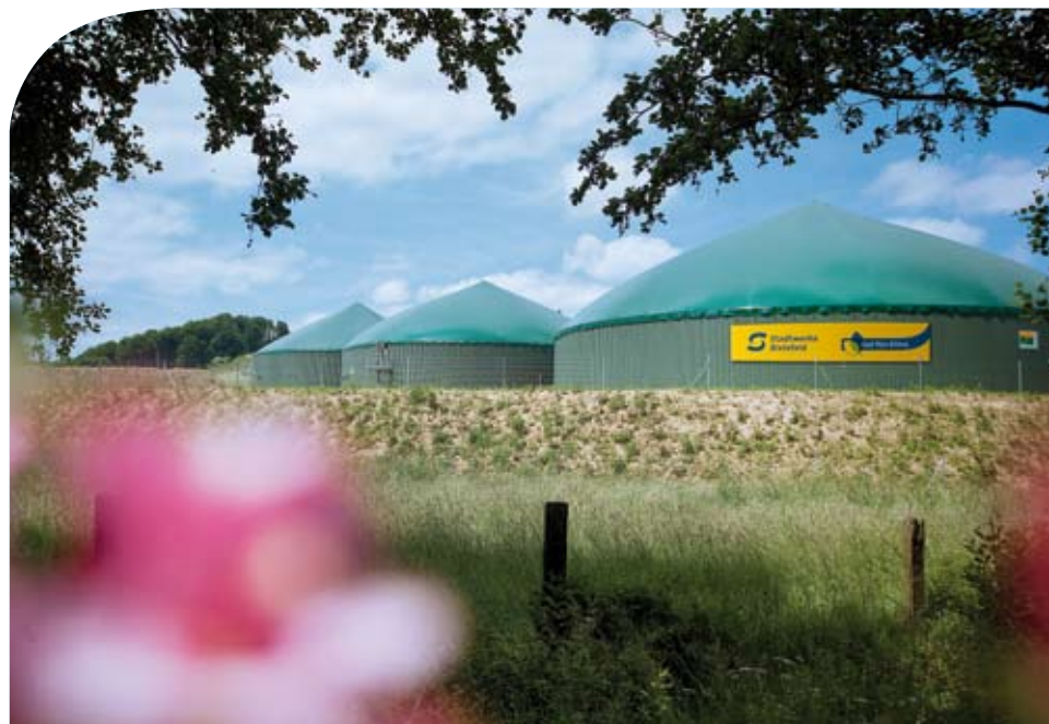
Die Biogas-Anlage in Niederdornberg
