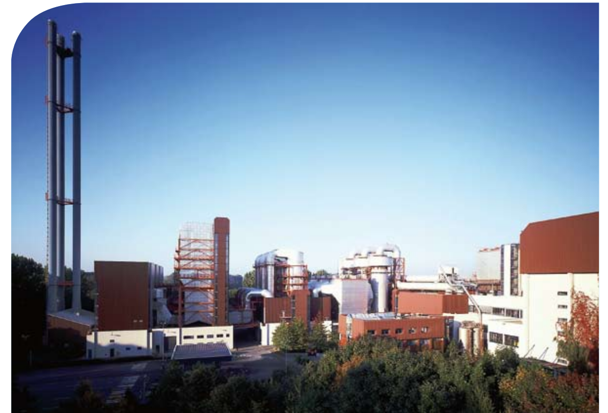
Die Müllverbrennungsanlage am Schelpmüser Weg in Bielefeld-Heepen
