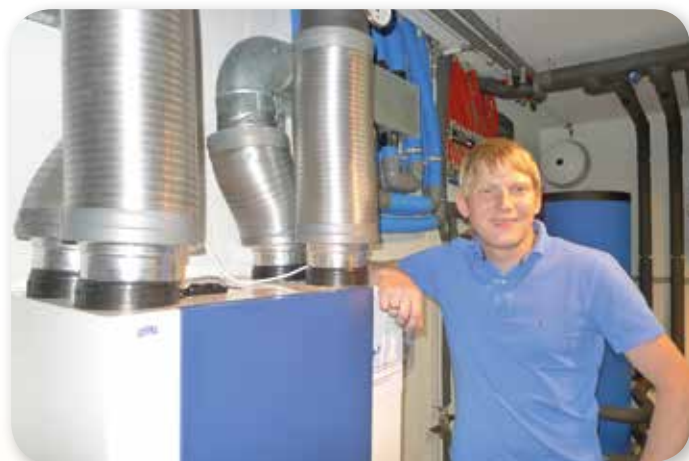
Thorsten Schröder hat in seinem Wohnhaus eine Lüftungsanlage mit Wärmerückgewinnung installiert, um die Frischluftzufuhr sicherzustellen.
