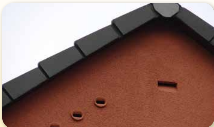
Fassadenquartiere für Mauersegler (li.) und Fledermäuse (o.)
