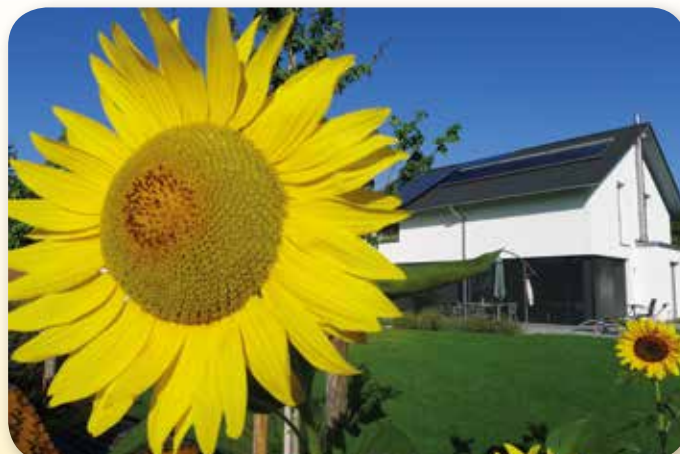
Die Außenfassade des Hauses ist mit einem 30-cm-Vollwärmeschutz ausgestattet. Große nach Süden ausgerichtete Fensterflächen dienen als Luft-Solarkollektor.
