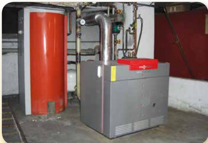
Die alte Schwerkraftheizung wurde durch eine neue Gasheizung ersetzt, die aber nur wenige Monate im Jahr gebraucht wird.
