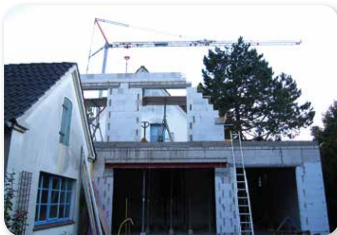
Das alte Wohnhaus und das Werkstattgebäude wurde durch einen Anbau miteinander verbunden
