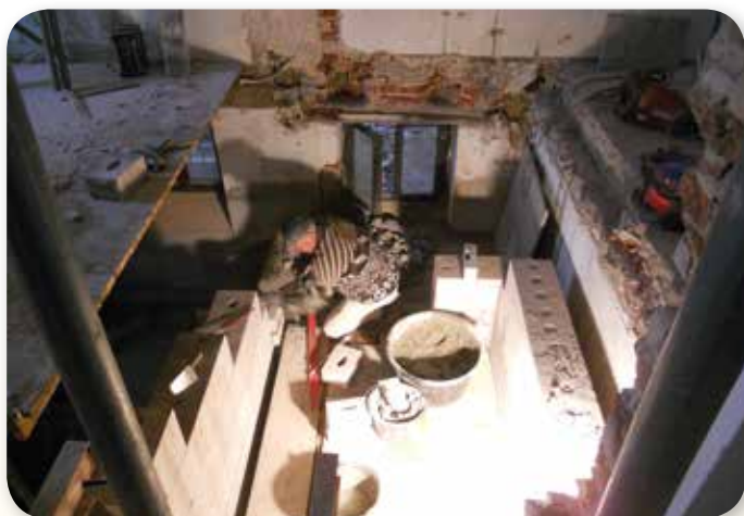
Diese gelungene Sanierung wurde mit dem ersten Gütersloher Altbaupreis ausgezeichnet.
