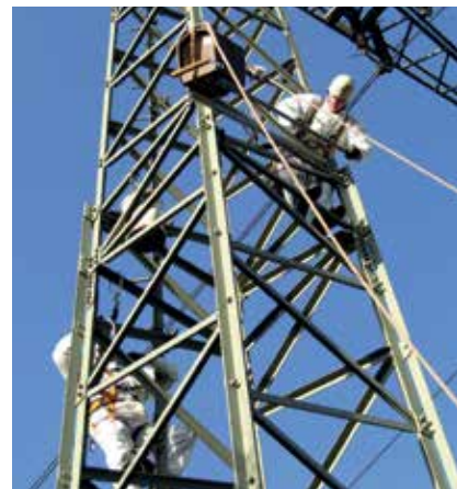
Montage der Nisthilfe im Hochspannungsmast Foto: R. Gildhuis
