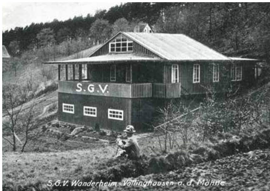
Das Wanderheim in Völlinghausen kurz vor der Fertigstellung
