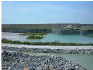
Abb. 7 Steinbruch in Geseke
