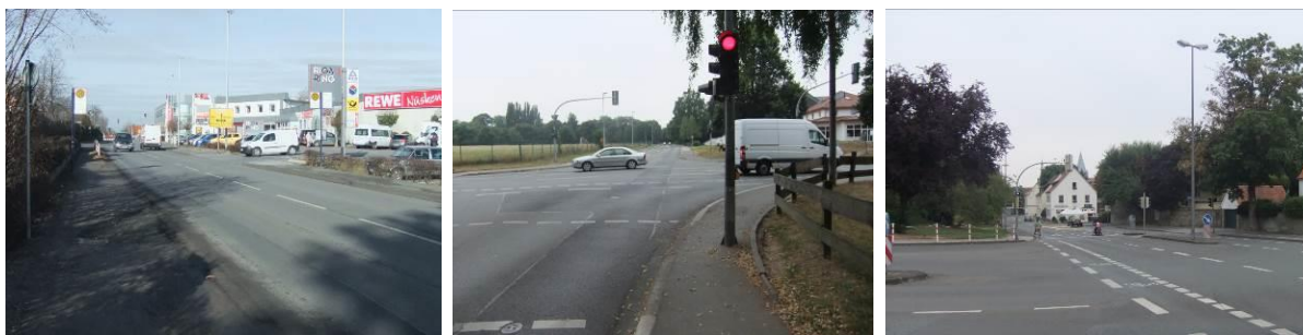
Abb. 56: Netzlücke Opmünder Weg, Hiddingser Weg/Waldweg, Kreuzung Grandwegertor
