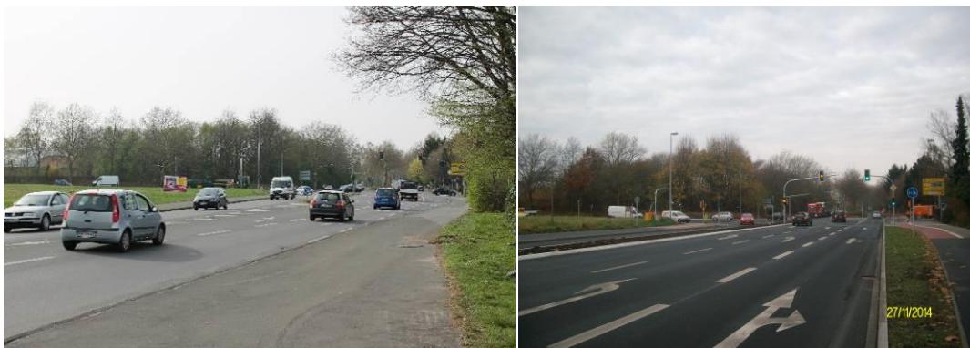
Abb. 34: Ortseinfahrt Arnsberger Straße (links: vor Umbau, rechts: nach Umbau)
