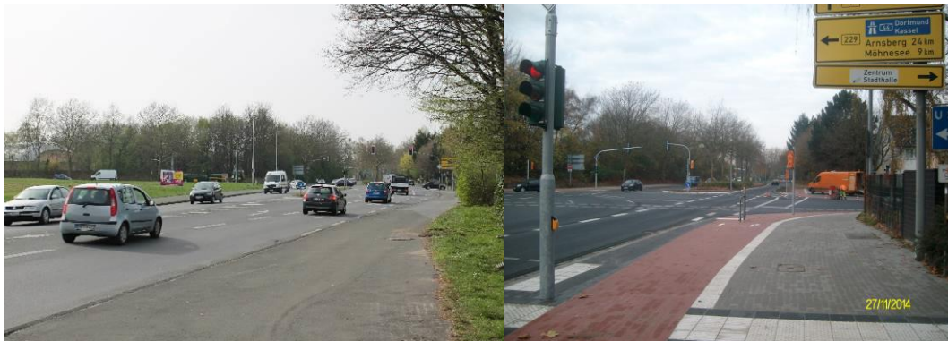
Abb. 64: Knoten Arnsberger Straße / Wisbyring (links: vor Umbau, rechts: nach Umbau)
