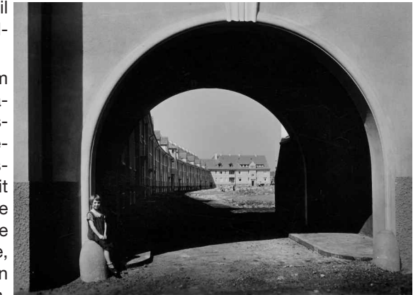
Torbogen Bayrische Straße
