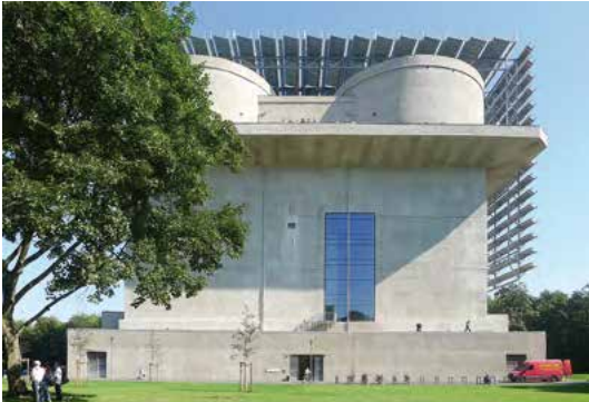
„Energiebunker“ IBA Hamburg
