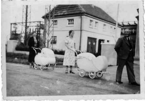
An der Elektrizitätszentrale
