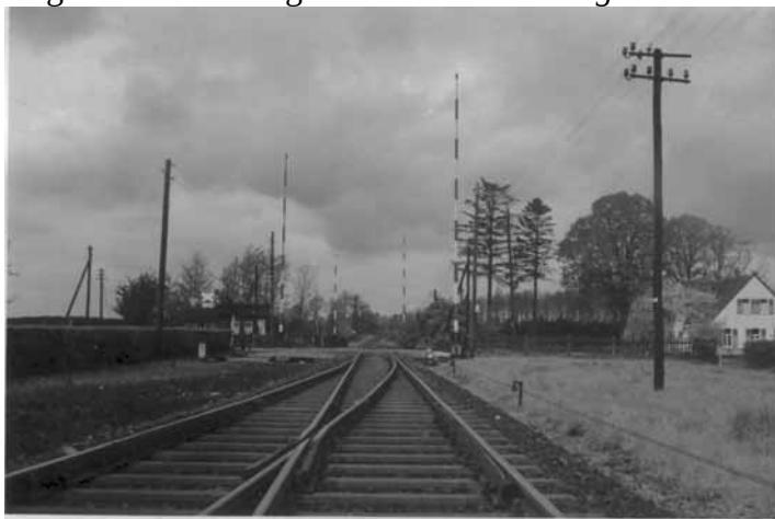
Straßengleicher Bahnübergang an Metelen-Land
