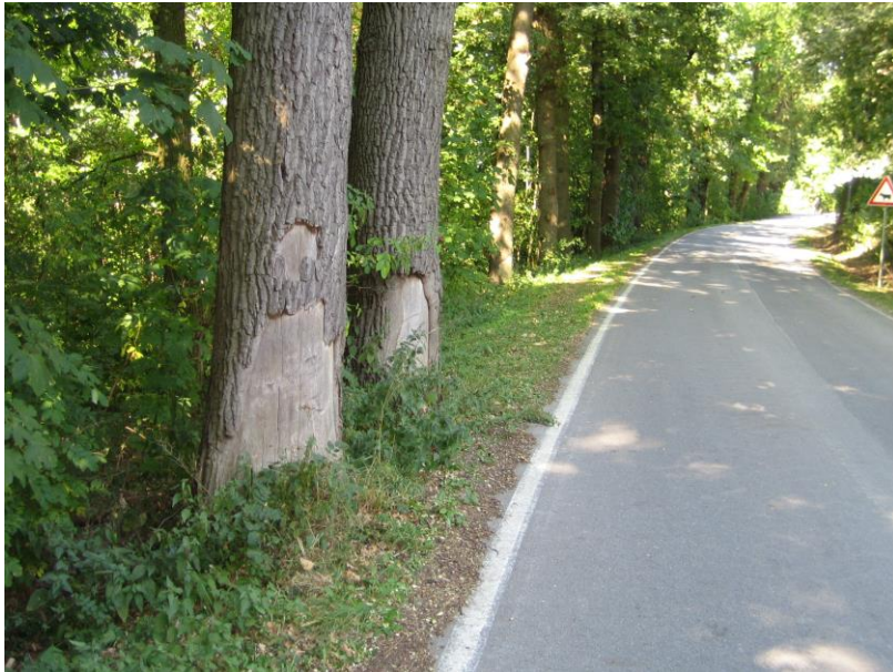
Baumschäden durch Verkehrsunfall – K 64 bei Klieve
