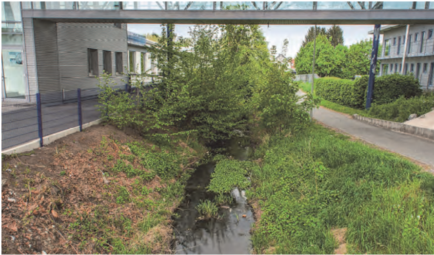
Überbaut: Rothebach an der Detmolder Straße
