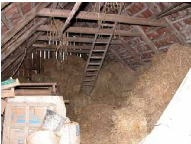
Abbildung 14: Der ehemalige Heuboden 2005 Foto: U. Nolte
