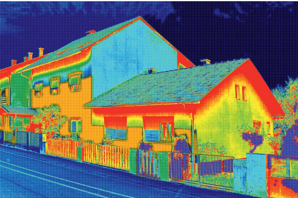
Rot, Pink und Gelb zeigen in der Infrarotaufnahme Wärmeverlust an.
