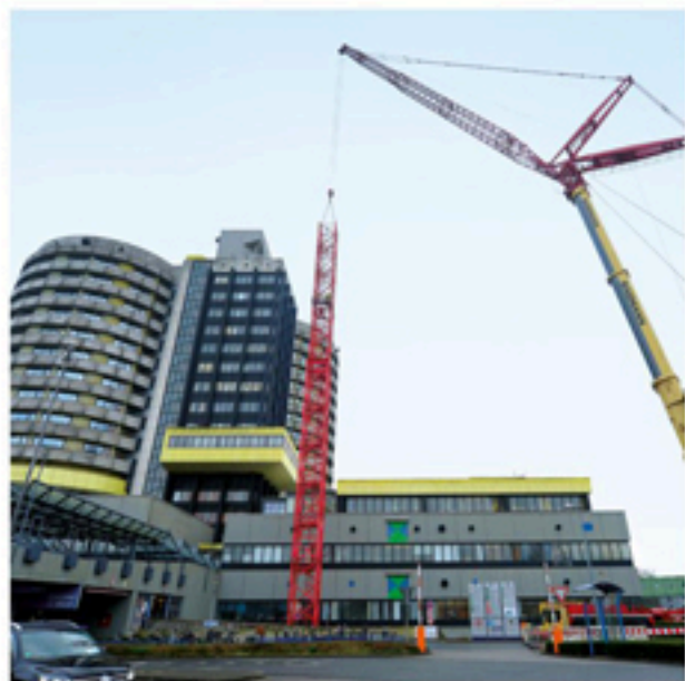
Hoch hinaus: 96 Meter hoher Kran zum Start der Fassadenrenovierung
