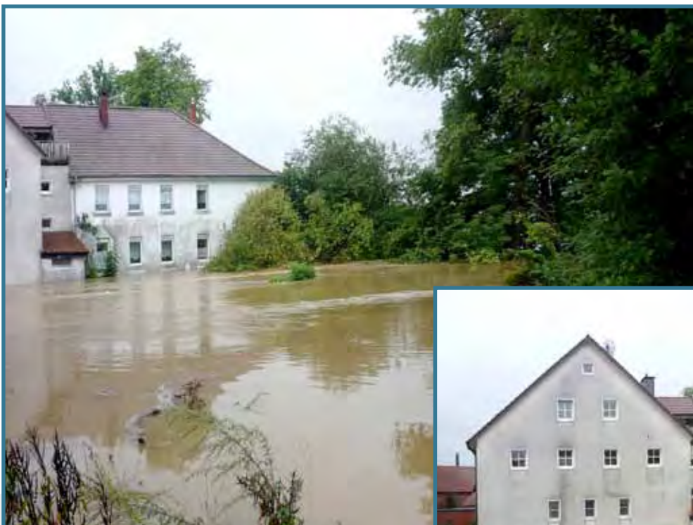
Ansicht während des Hochwassers
