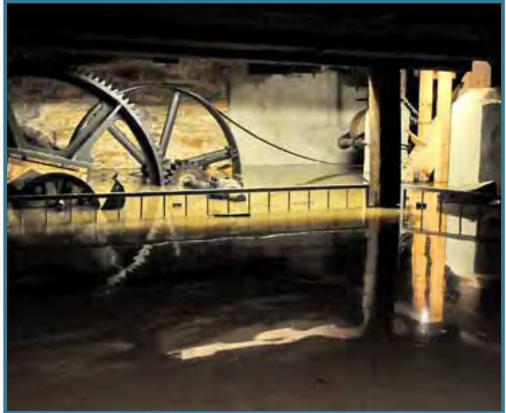
Aufnahme von den Kellerräumen im Restaurant Schlossmühle
