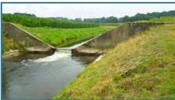
Einschnürungsbauwerk bei normaler Wasserführung
