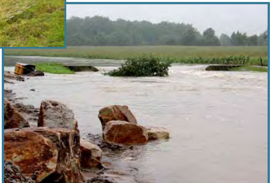
Einschnürungsbauwerk beim Hochwasser
