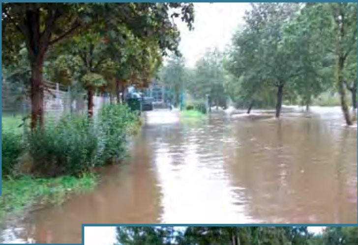
Zufahrt zum Hauptpumpwerk
