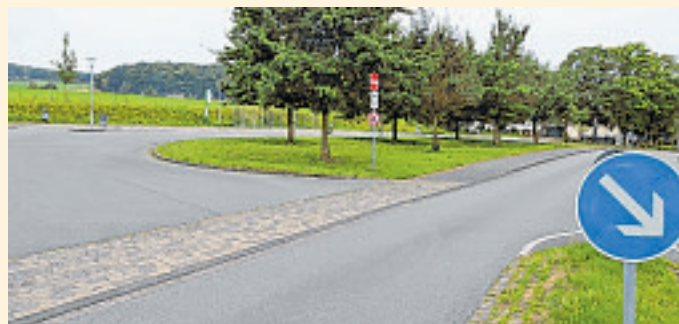
Baustelle: Auf dieser Grünfläche entstehen Parkplätze. Die Baumreihe im Bildvordergrund bleibt erhalten. FOTO: ANDREAS GROSSPIETSCH
