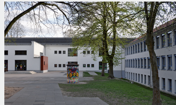
GS Hohenstaufenschule: Sanierung Teilneubau, Außenanlage
