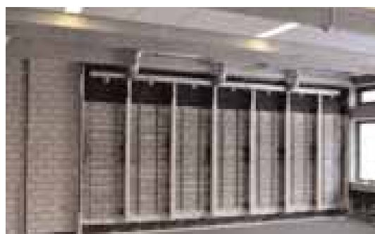
Abb. 8-3: Klimawand im Rohbau
