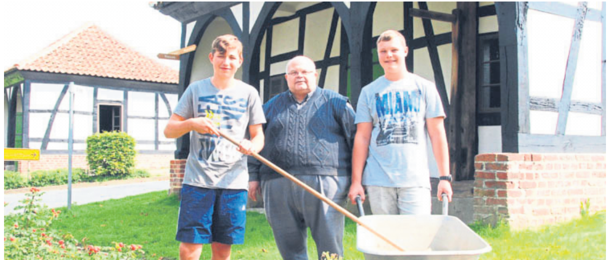
Schweckhausens Ortsbürgermeister Hans-Jürgen Schmitt hatte während der Restaurierungsarbeiten zahlreiche Helfer aus dem Ort. Auch die beiden 14-jährigen Jungen Oliver Riep (links) und Jannik Heinbrock gehören zum Helferteam. Fotos: Ulrich Schlottmann
