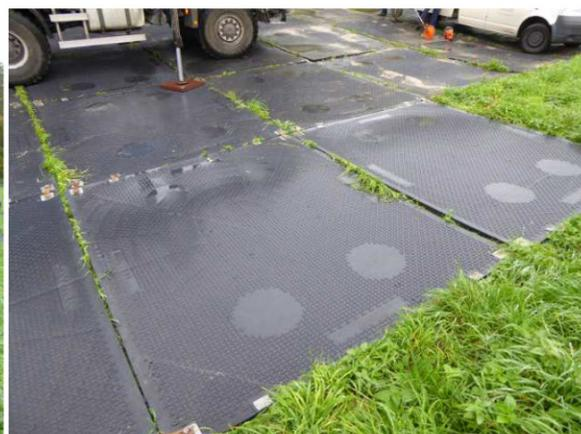
Fotos zur Bauausführung auf dem Grünland im Bereich einer Baueinrichtungsfläche; Verlegung von Kunststoff-Hartplatten zur Druckverteilung
