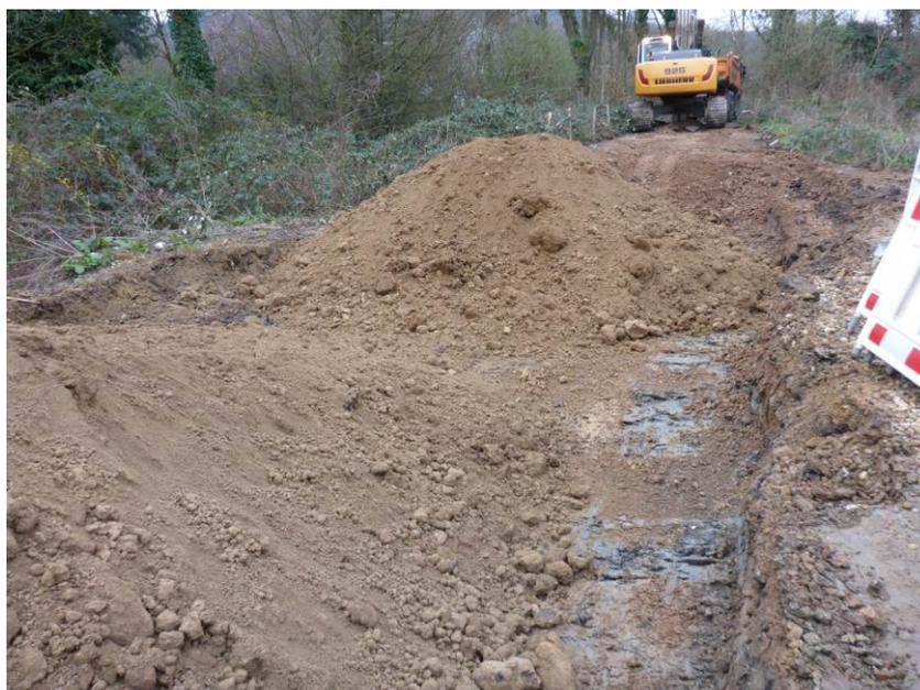
April 2016: Bereits zurückgebauter Baustraßenabschnitt mit angeschüttetem Unterbodenmaterial
